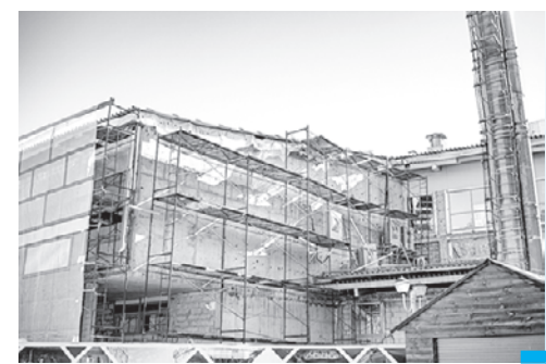
Реконструкция в «Жемчужине Сибири» идёт полным ходом
